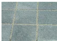
Betonpflaster mit Splittfuge
