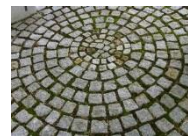
Granitpflaster mit Splittfuge
